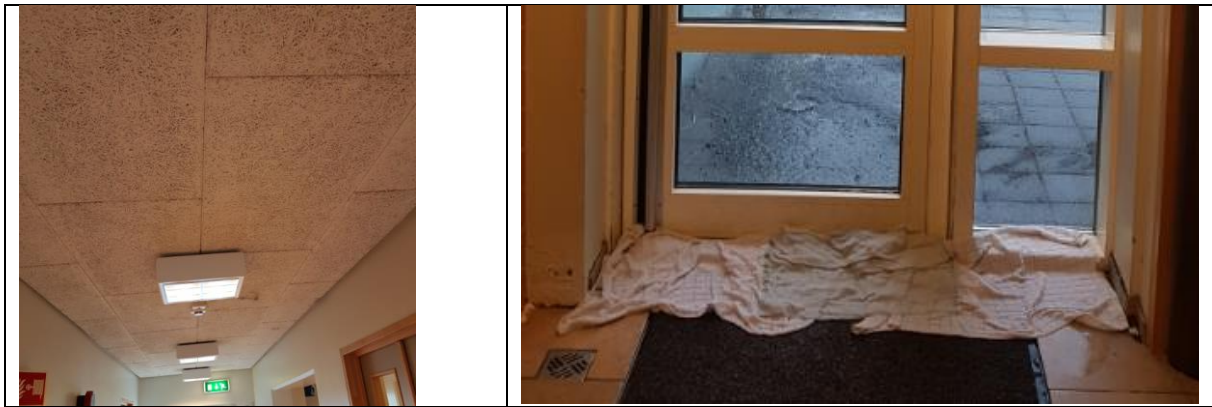
Mynd. Laga hljóðvist og skipta ú ljósum í lofti. Laga aðgengi fatlaðra um útihurðar.
