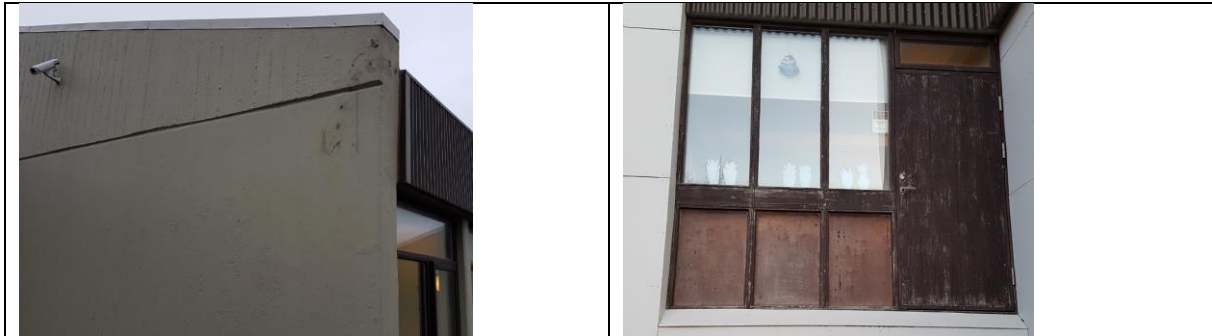
Mynd. Mála útvegg eftir sprunguviðgerðir. Bera á timburverk.
