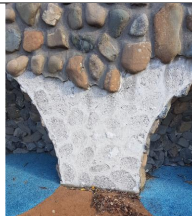
Mynd. Geymsla undir palli austanmegin er lek. Steinklæðning á geymslunni er hrinin af að hluta.
